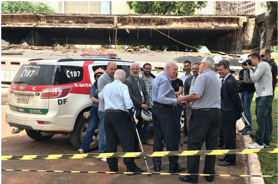
Figura 6 – Engenheiro Contarini no local do desabamento do viaduto da Galeria sobre os Estados – 7/2/2021
