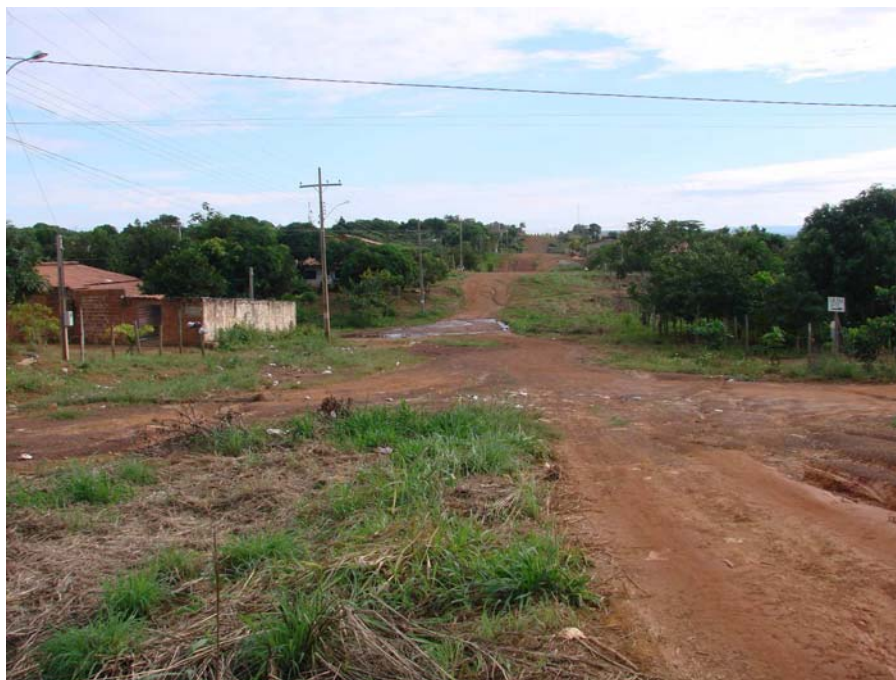
FOTO 14: Transposição de uma via pública pelas águas da terceira nascente
