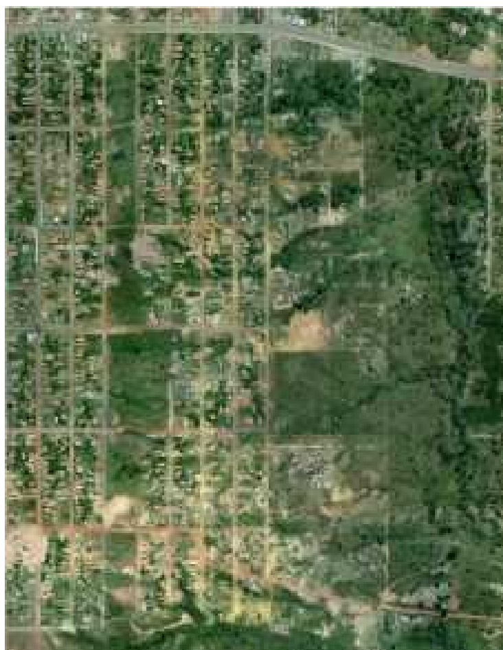
FOTO 3: Ruas interrompidas e quadras desocupadas no loteamento
