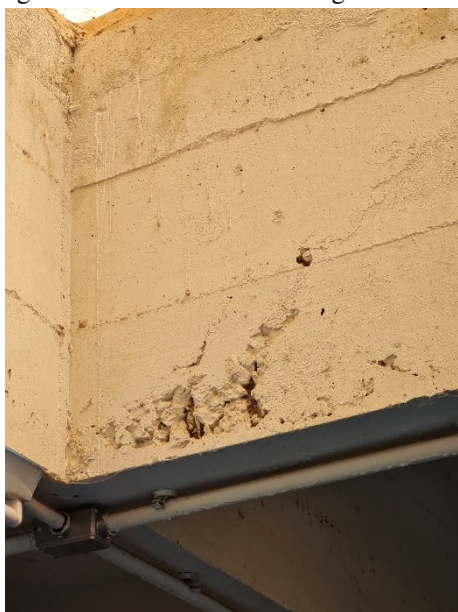
Figura 152 – Nicho de concretagem na vida.
