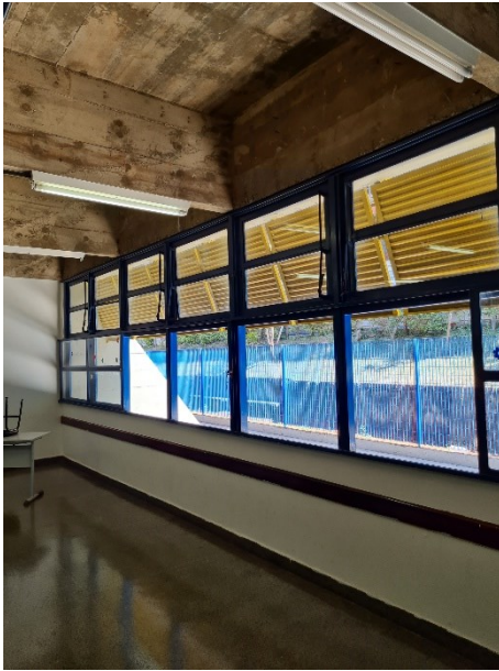
Figura 131 – Esquadria metálica.
