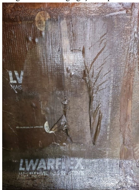
Figura 66 – Desagregação da película.
