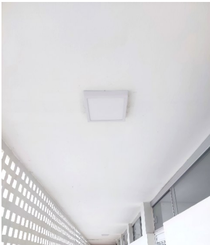
Figura 59 – Forro de gesso do hall de serviço.
