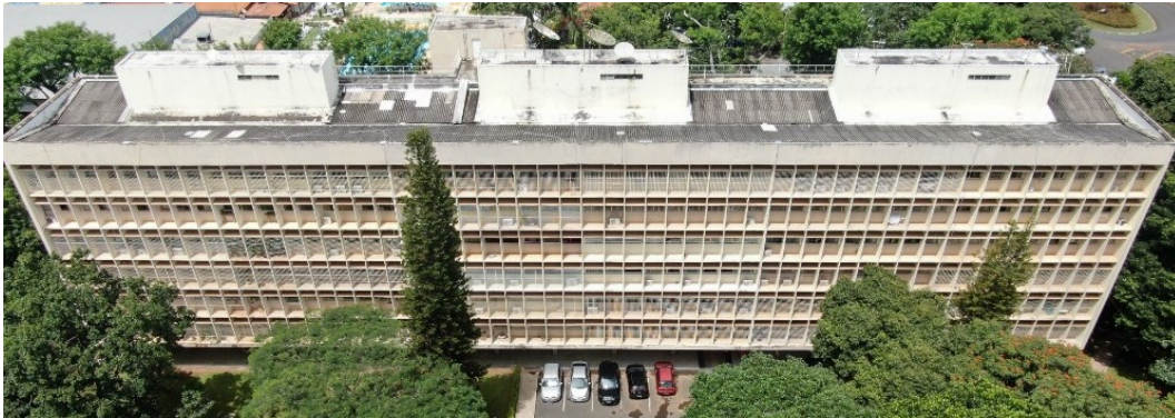
Figura 47 – Fachada frontal com brises de concreto (quebra-sóis).
