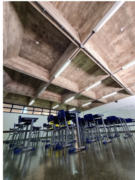
Figura 134 – Laje aparente.
