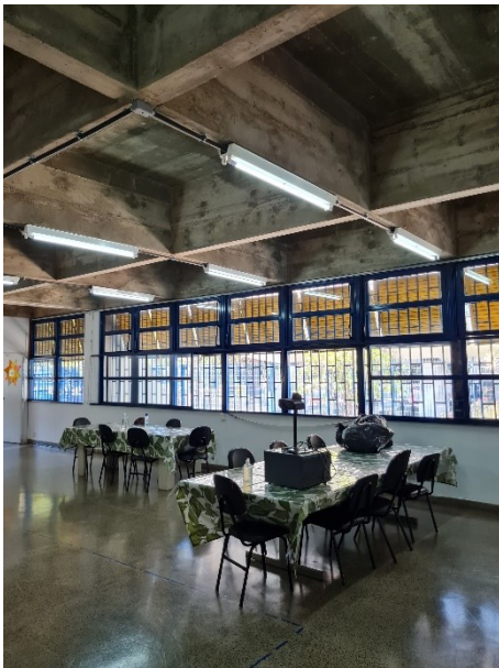
Figura 133 – Laje aparente.
