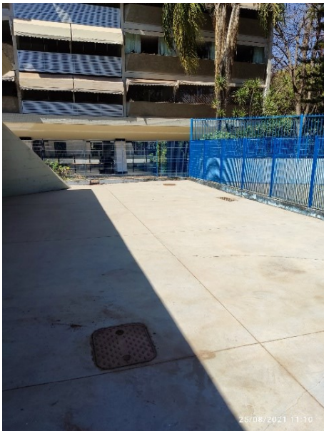
Figura 137 – Piso do pátio externo.
