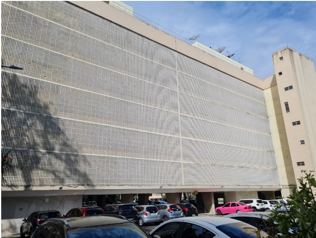
Figura 48 – Fachada posterior em cobogós e acesso de serviço em anexo.
