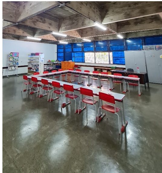
Figura 136 – Piso da sala dos professores.
