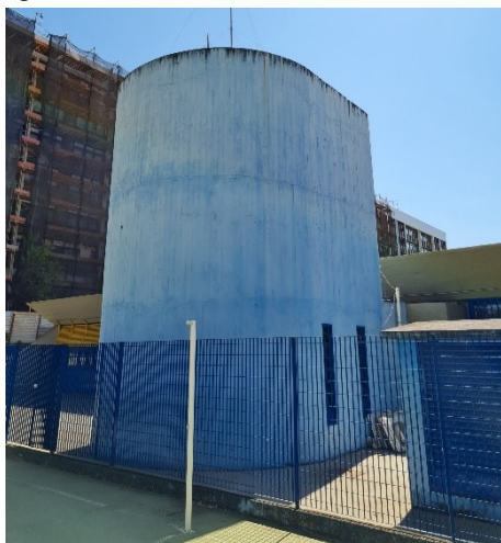
Figura 141 – Reservatório de abastecimento.
