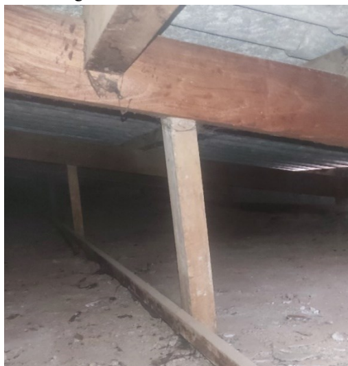
Figura 22 – Estrutura do telhado.
