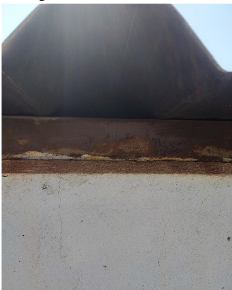
Figura 90 – Estrutura do telhado.
