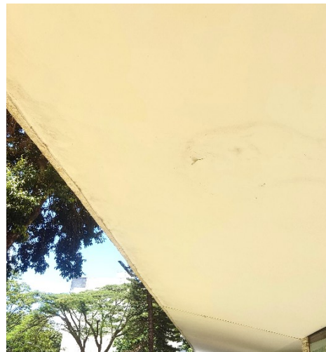
Figura 60 – Forro de gesso do pilotis.
