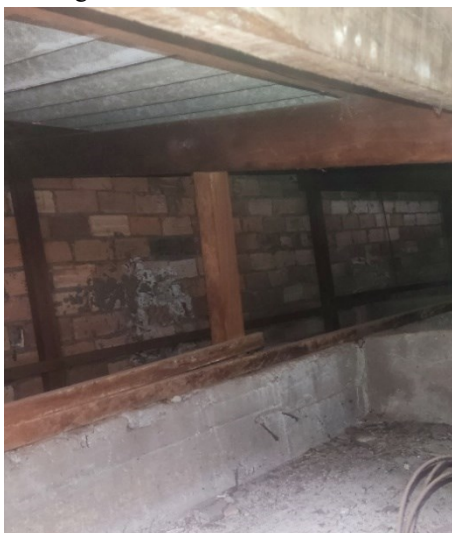
Figura 21 – Estrutura do telhado.
