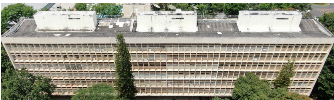
Figura 18 – Fachada da edificação objeto de estudo.
