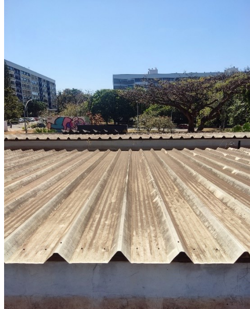
Figura 89 – Telhas metálicas de cobertura.
