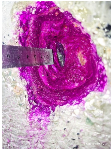
Figura 77 – Ensaio para medição da profundidade da frente de carbonatação.
