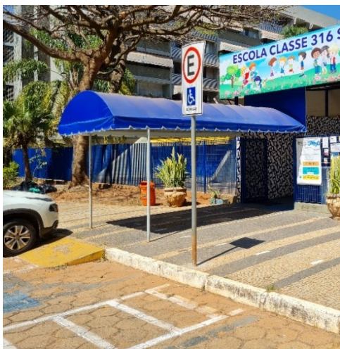
Figura 139 – Calçamento externo para acesso a escola.
