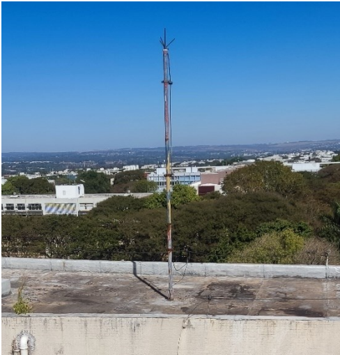
Figura 45 – Captores tipo Franklin.
