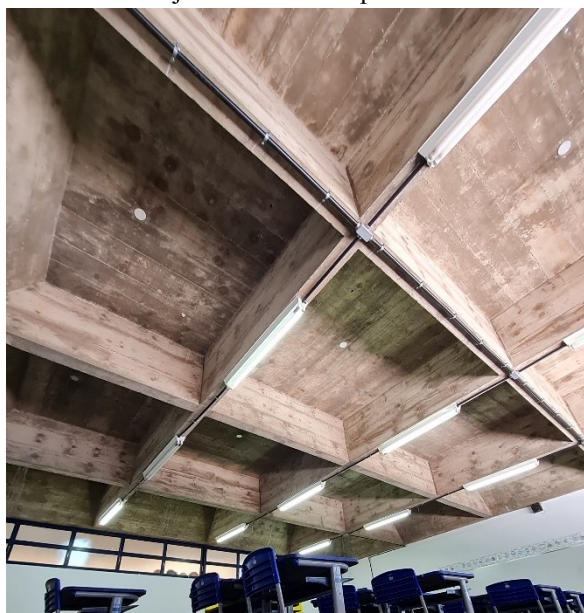
Figura 151 – Tipologia estrutural da edificação – vigas e lajes em concreto aparente.
