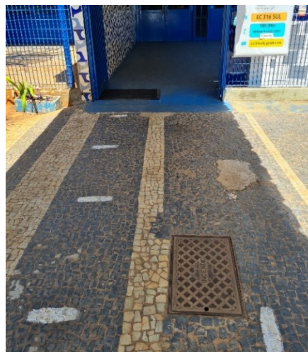
Figura 140 – Calçamento externo para acesso a escola.
