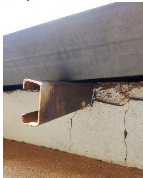
Figura 91 – Estrutura do telhado.
