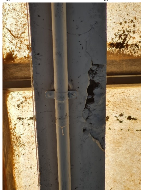
Figura 153 – Nicho de concretagem na vida.
