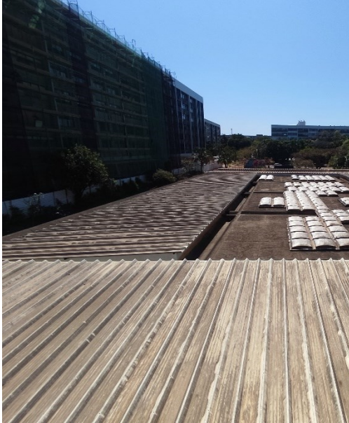
Figura 88 – Telhas metálicas de cobertura.
