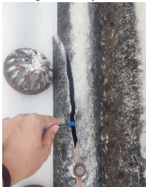
Figura 20 – Telha quebrada.
