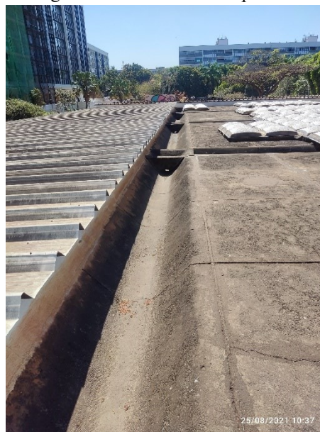
Figura 93 – Calha coletora pluvial.
