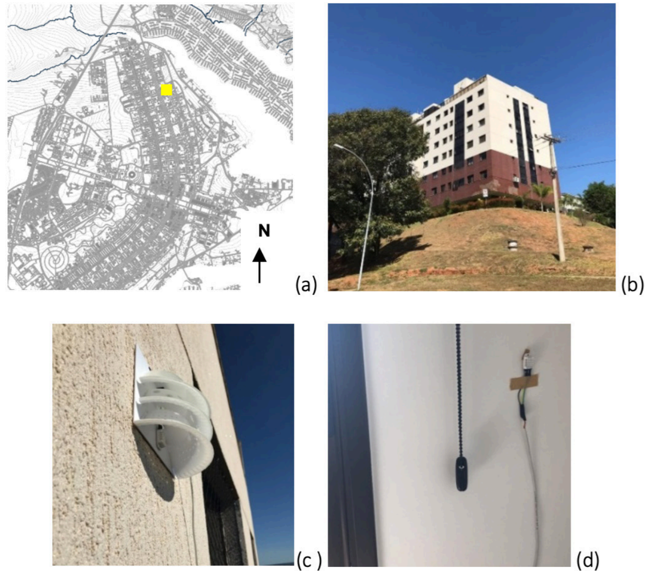
Figura 5: Edifício em altura: (a) Localização; (b) Fachada Leste; (c) Sensor DTH22 posicionado na face externa da parede; (d) Sensor DTH22 posicionado na face interna da parede.
