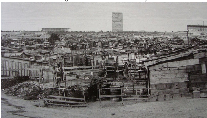
Figura 1 - Vista da Vila Amaury.
