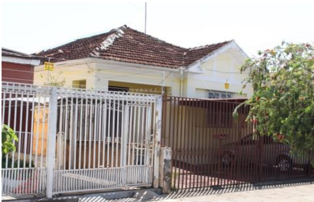
Figura 39 - Portas de pedestres/garagem e portão de garagem na Rua 55 - Centro Antigo de Goiânia Fonte: Juliana Arrais e Gerson Neto (2015) – (Créditos).
