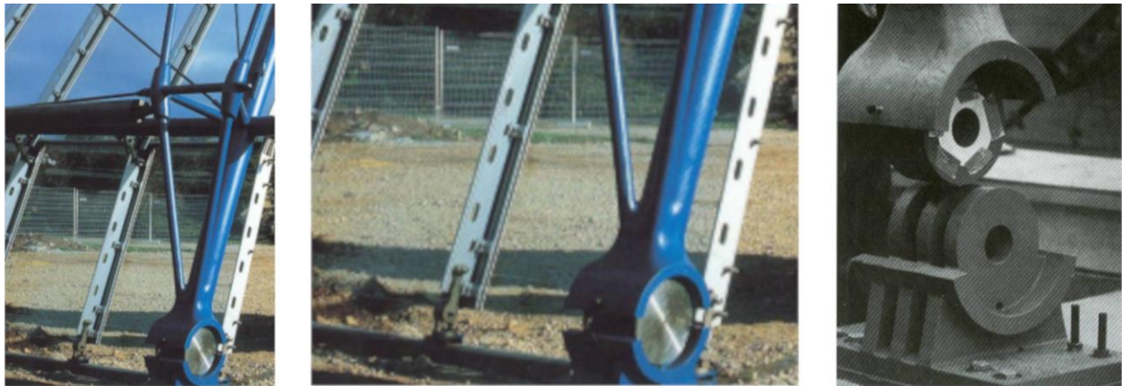
Figura 44: Junta de suporte a estrutura. (Powell, K. apud.: ÇINGI, 2007, p.95)
