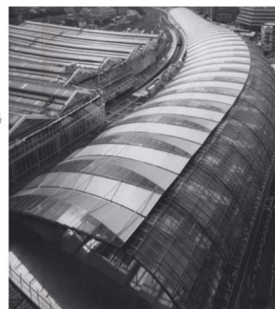
Figura 43: Estrutura dos arcos de cobertura. (Fonte: owl.net.rice.edu/~arch214/waterloo.pdf. Last accessed in November 2006. apud.: ÇINGI, 2007, p.100-102)
