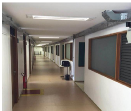
Figura 2.13: Corredor do 1º andar
