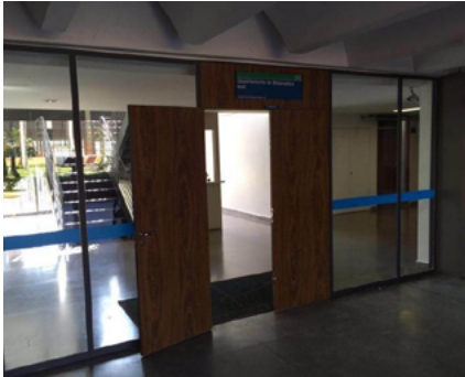
Figura 2.5: Entrada atual do MAT
