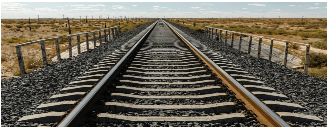
Figura 27 – Trecho da FIOL em obras
