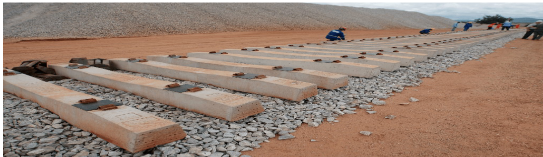
Figura 26 – Trecho da FIOL em obras
