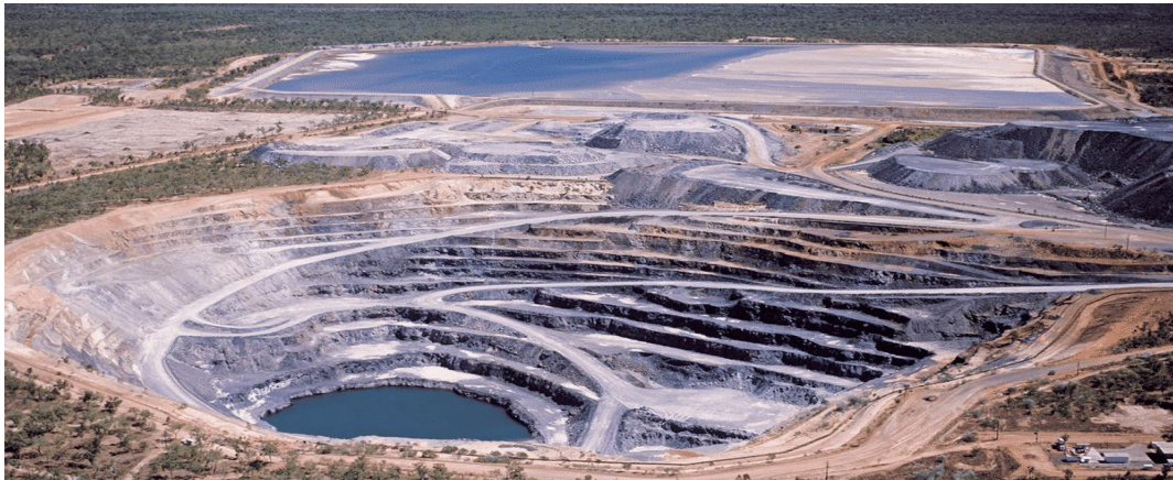
Figura 3 – Escavações decorrentes dos processos de lavra da jazida terrestre
