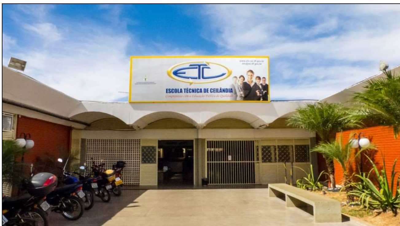
Polo Ceilândia - Escola Técnica de Ceilândia
