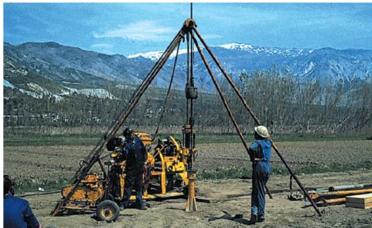
Figura 2.17: Equipamento utilizado no ensaio SPT (Vallejo e Ferrer, 2011)
