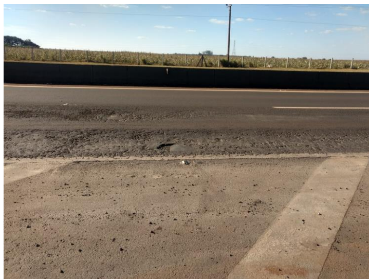
Figura 3-2 – Trecho experimental antes da restauração.
