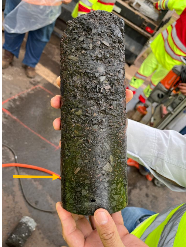
Figura 4-20 – Corpo de prova extraído do campo com indicação da interface entre o revestimento asfáltico e a base.
