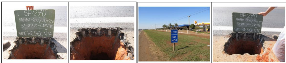
Figura 3-3 – Sondagem Trecho Experimental – julho/2021 (CART)
