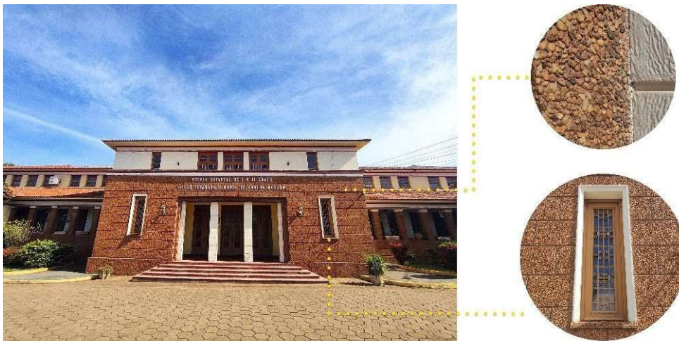
Figura 2. Fachada principal do Colégio Liceu Cuiabano, antigo Colégio Estadual e detalhe do revestimento e das janelas da entrada principal.
