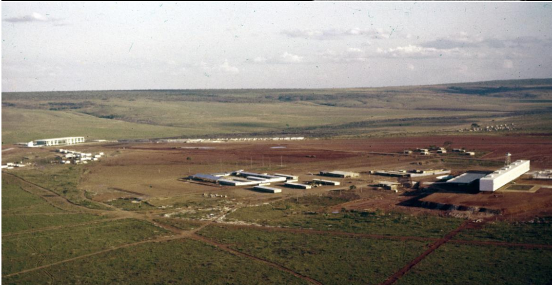
Figura 5: Vista aérea da situação do Palácio da Alvorada e do Brasília Palace Hotel, 1958, em comparação com a primeira maquete elaborada em 1956. Fonte: Arquivo Público do Distrito Federal.
