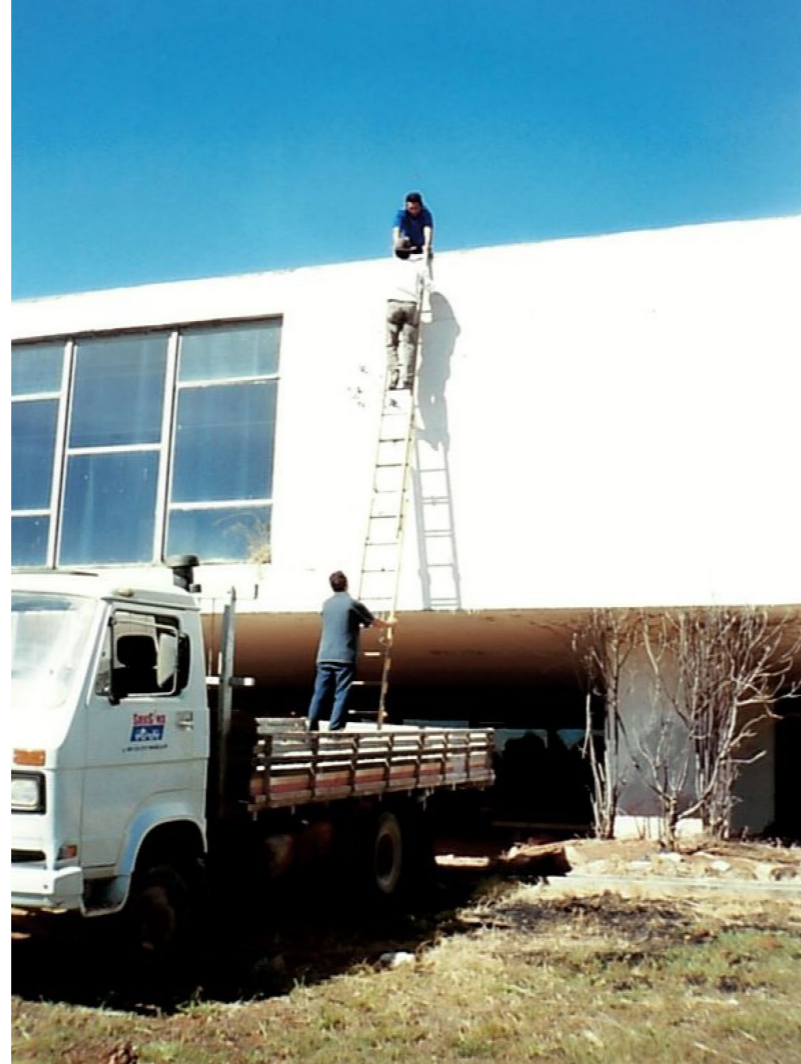
38. Encarregados fazem reparos na laje de cobertura do MAB.
