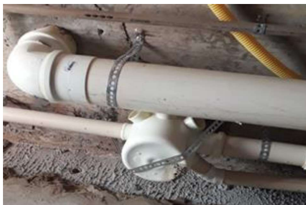
Figura 1 – Caixa sifonada fixada com fita metálica.
