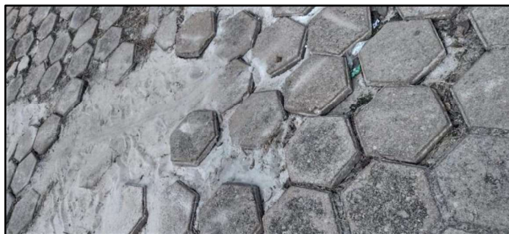
Figura 5 - Pavimento da praça pública em concreto intertravado
