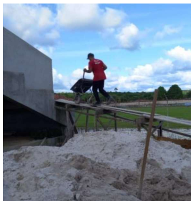
Figura 4 - Rampa de acesso
