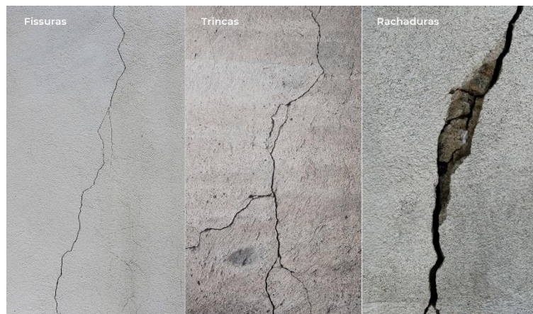
Figura 1 – Comparativo entre fissuras, trincas e rachaduras [8]
