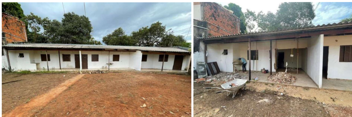
Figura 5 – Obra em andamento.
