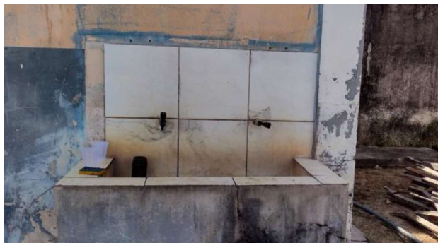
Figura 7 - Bebedouro utilizado pelos funcionários do canteiro de obras
