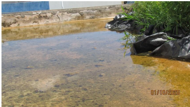
Figura 13 – Retirada do substrato e camada vegetal da área para reparo das fissuras.
