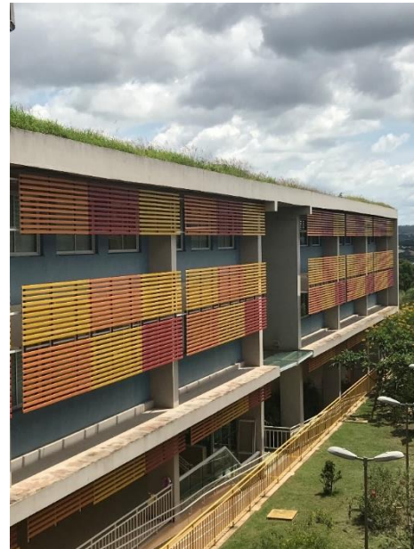
Figura 7 – Fachada do Bloco B - cobertura verde
