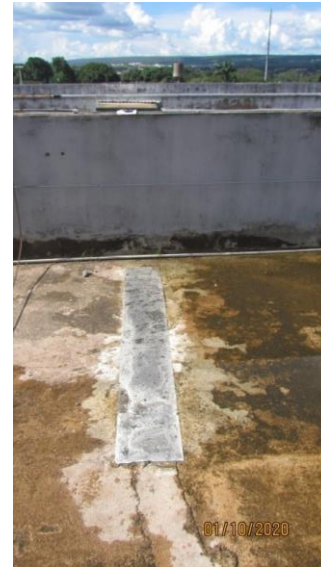
Figura 14 – Aplicação de faixa de material impermeabilizante sobre as fissuras da camada de proteção mecânica
