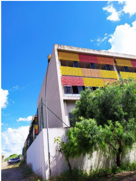
Figura 6 – Fachada NE/NO – sala de dança
