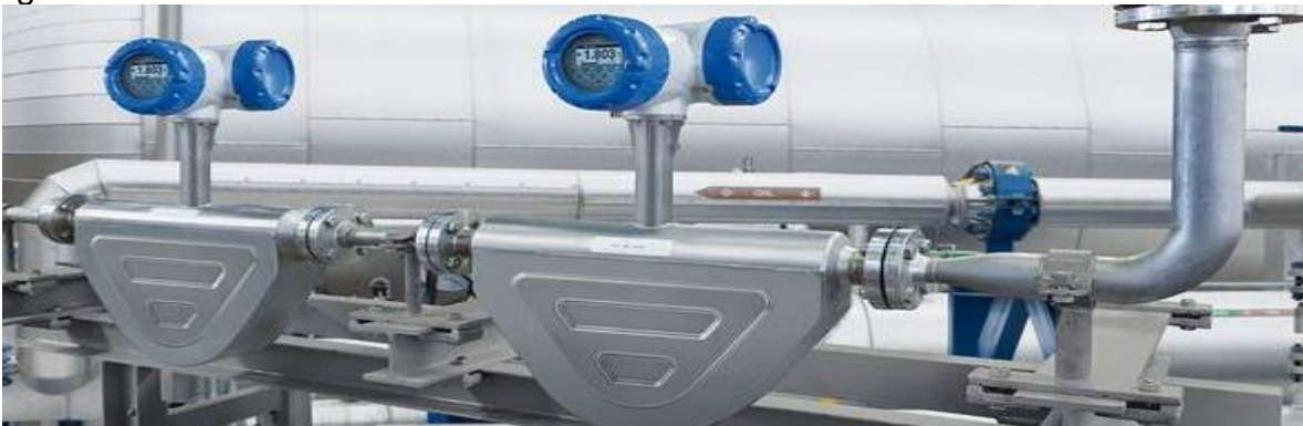
Figura 10 - Medidor de vazão mássica Coriolis.
