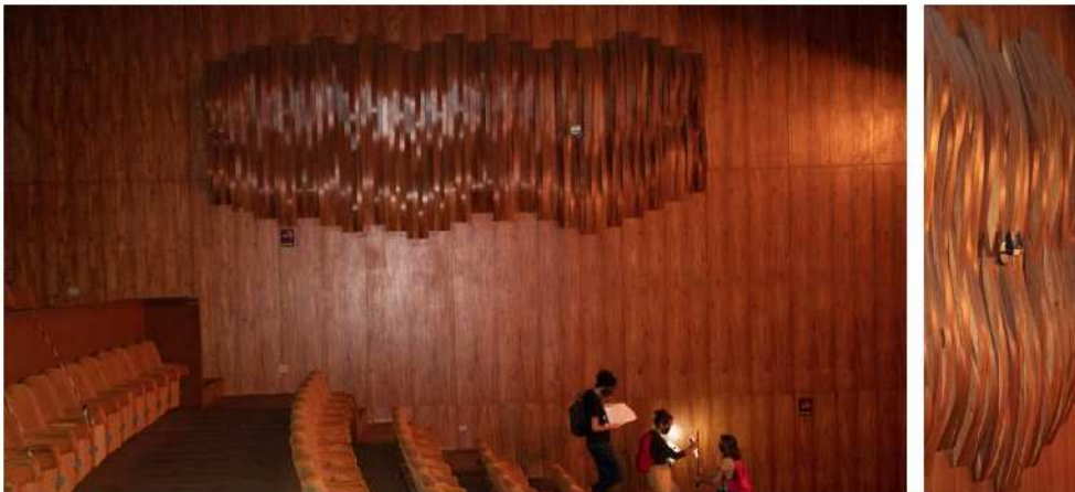
Figura 3 – Pannel de madeira – autoria Athos Bulcão – perfurado para instalar iluminação de emergência (fonte: acervo particular dos autores).
