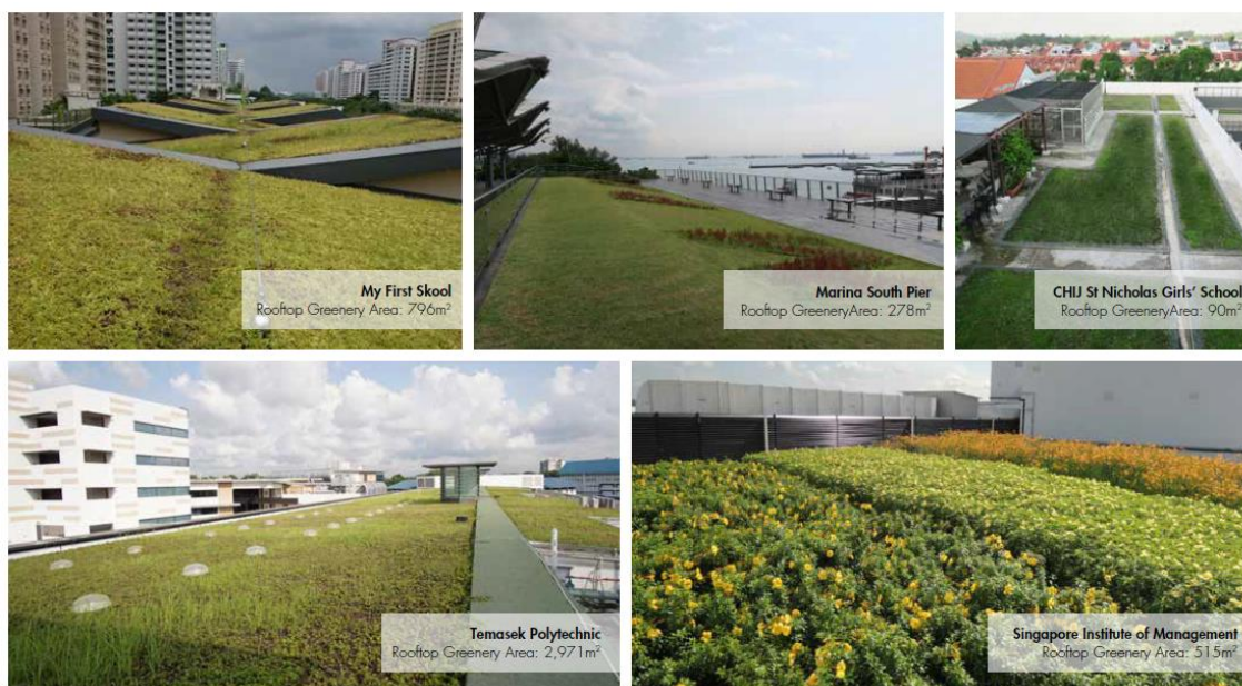
Figura 10 - Exemplos de coberturas extensivas em Singapura.
