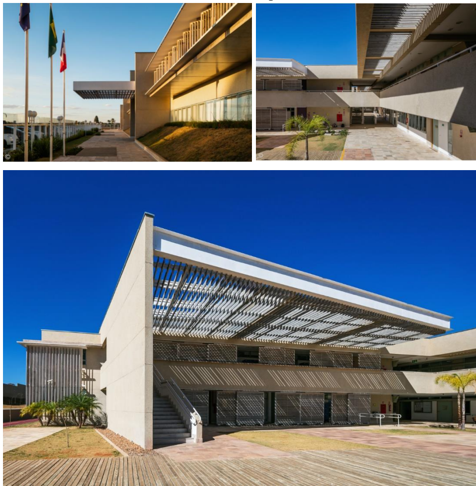
Figura 39 - Soluções bioclimáticas aplicadas às fachadas da edificação. Fachadas oeste, norte e leste, respectivamente.
