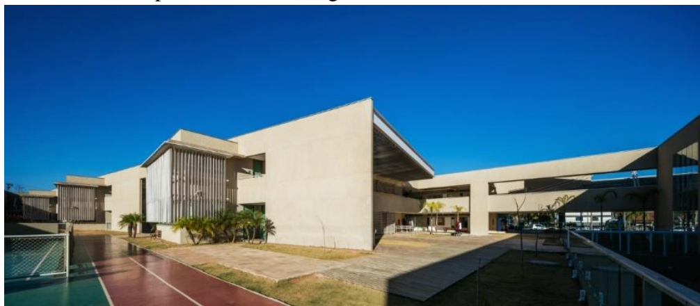
Figura 47 – Configuração arquitetônica externa do bloco da sala de aula em estudo composta por brises e beirais generosos. Fachada leste.
