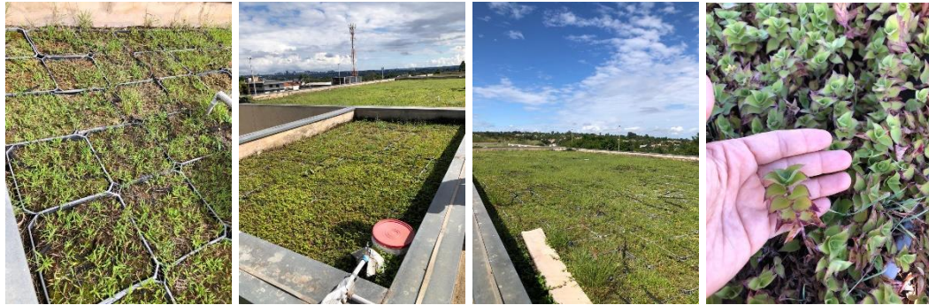
Figura 50 – Cobertura verde no dia das medições de temperatura do ar e umidade.
