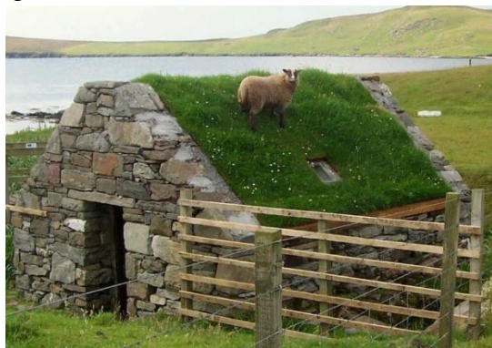
Figura 2 - Telhado escocês coberto com turfa.
