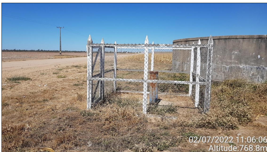
Foto 16 - Poço de monitoramento de nível da água subterrânea da RIMAS/CPRM.
