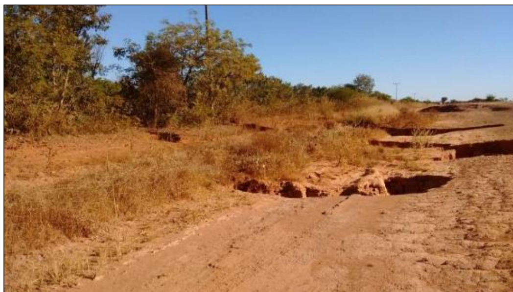
Foto 2 - Processos erosivos ( piping ) na margem da BA-459, com abatimento do solo e gerando uma voçoroca que liga a vários túneis.
