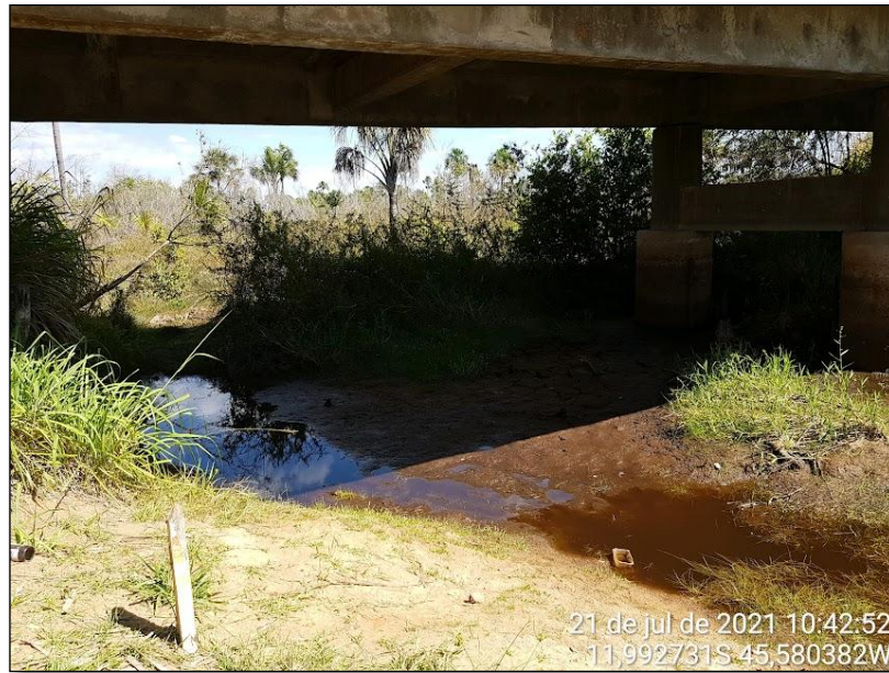
Foto 20 - Curso do rio Ponta D'Água sem água, localizado sob a ponte na rodovia BA-459.
