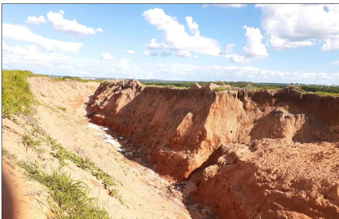
Foto 22 - Processos erosivos em latossolos, com voçorocas atingindo profundidades de aproximadamente 2 m.
