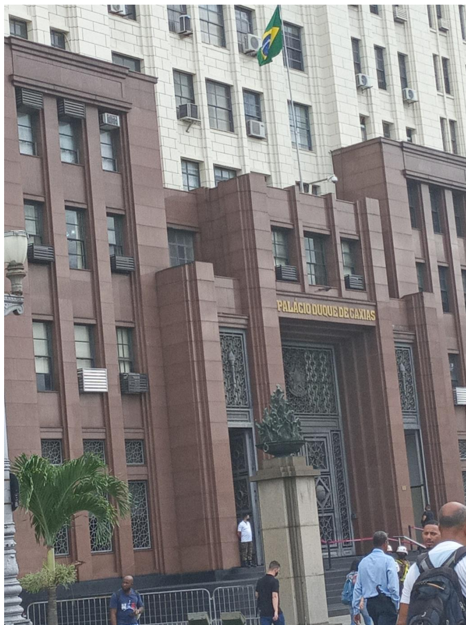
Fachada do prédio onde se localiza o AHEx-RJ, fevereiro de 2023.
