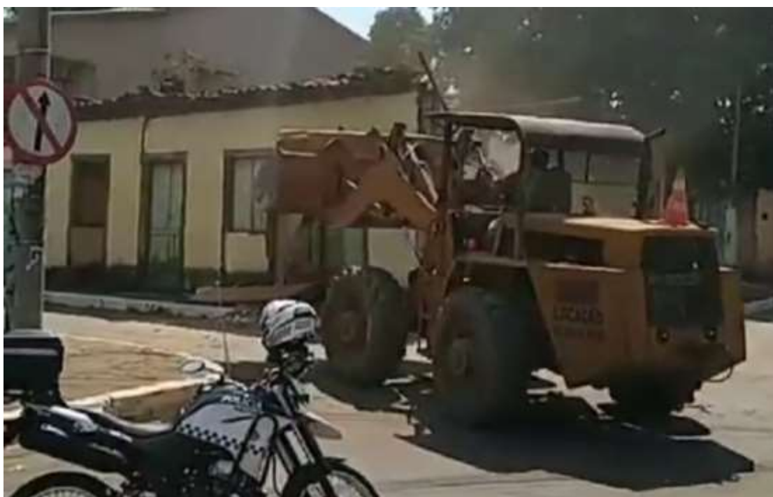
FIGURA 7 – Demolição da Casa da Dona Negrinha — Foto: João Angelini/ Acervo pessoal
