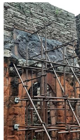
Figura 22 – Estrutura de sustentação das paredes das ruínas, maio 2022
