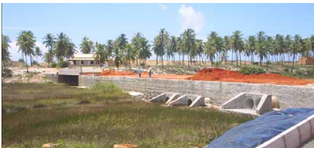
Foto 7: Reserva Imbassai, intervenção para travessia da área alagadiça e ponte.
