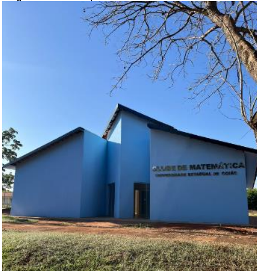
Figura 8 - Construção da Sede do Clube de Matemática
