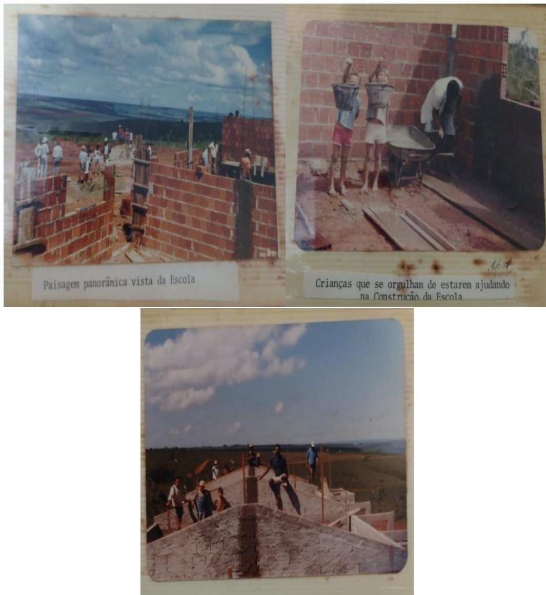
Figura 2 – Mutirão para a construção do Centro Educacional Casa Grande, 1985
