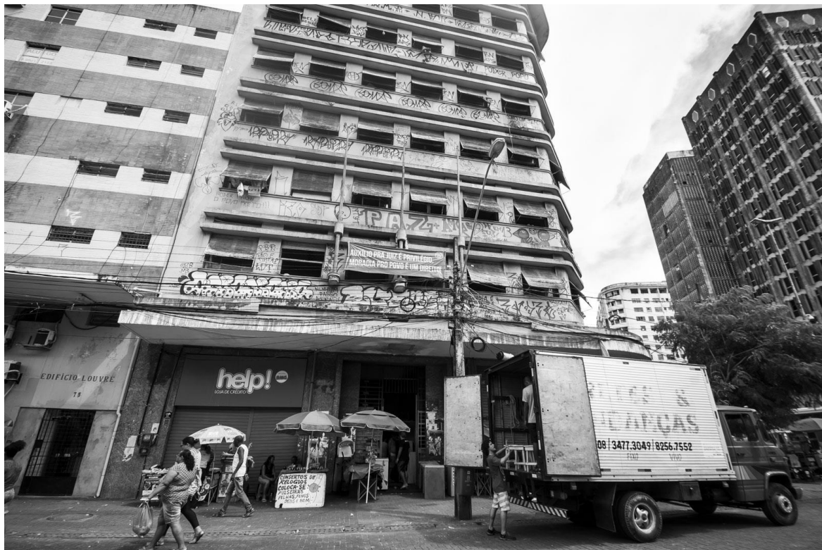
Fig. 03 Desocupação do Edifício Sulamérica pelas famílias da Ocupação Marielle Franco em 2019. Fonte: (Marco Zero Conteúdo, 2019).
