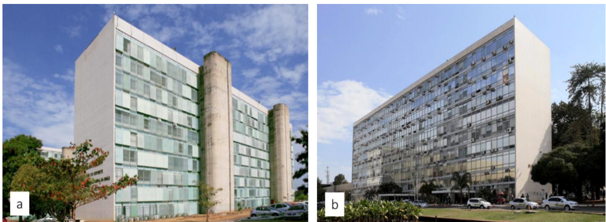
Figura 2: Fachadas Oeste (a) e Leste (b) do edifício M2
