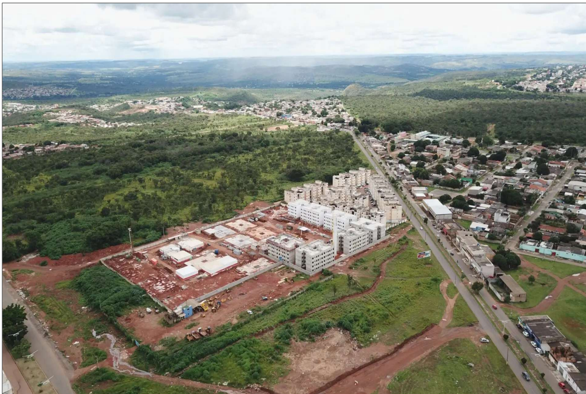
Figura 23: Fotografia área dos Residenciais Viva Vida em construção, no bairro Núcleo Habitacional Novo Gama
