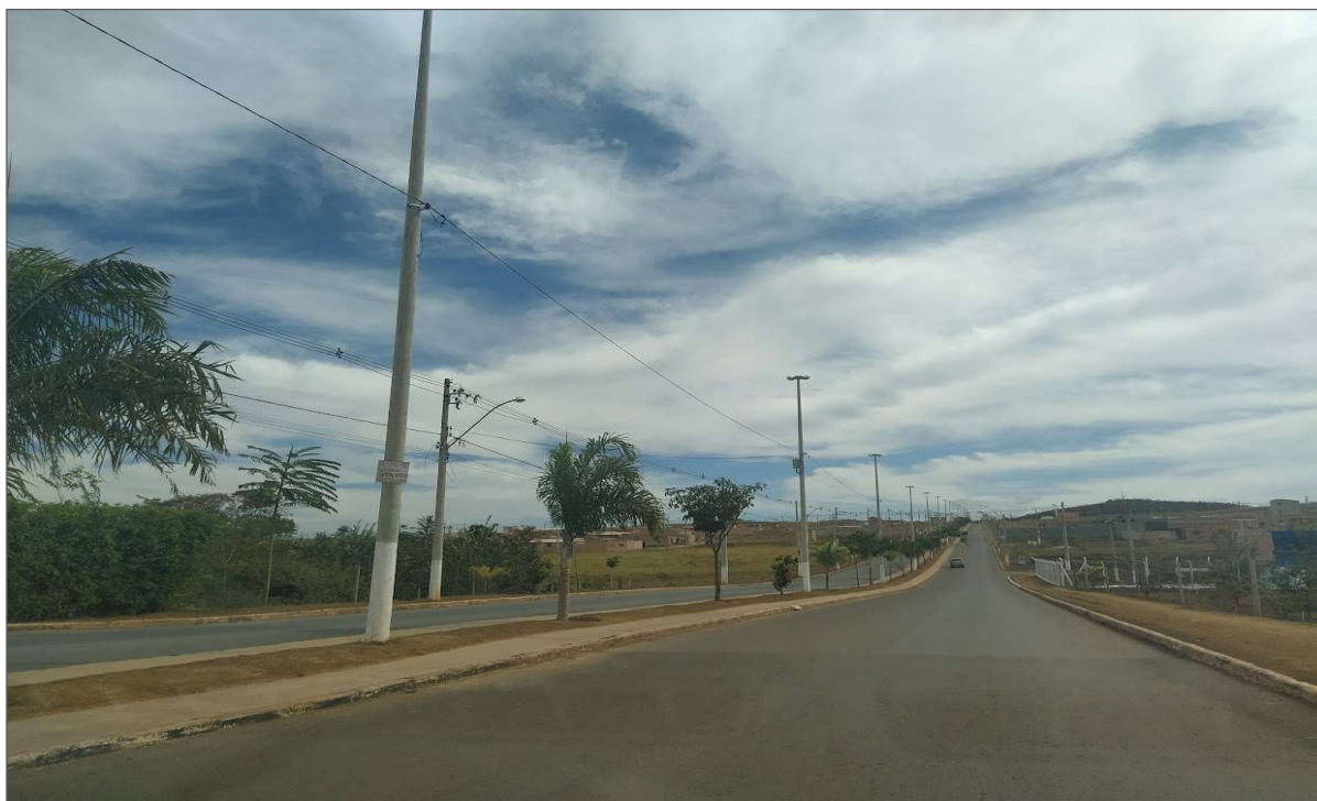
Figura 45: Área onde estão localizados os Residenciais do bairro Parque Estrela Dalva VI
