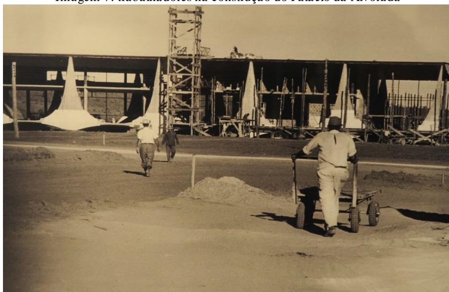
Imagem 7: trabalhadores na construção do Palácio da Alvorada
