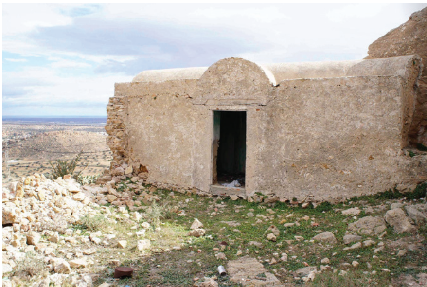
Fig. 139 – Ruína da casa utilizada para a instalação Água Viva – Takrouna/Tunísia. Foto Alina Duchrow. 2013.
