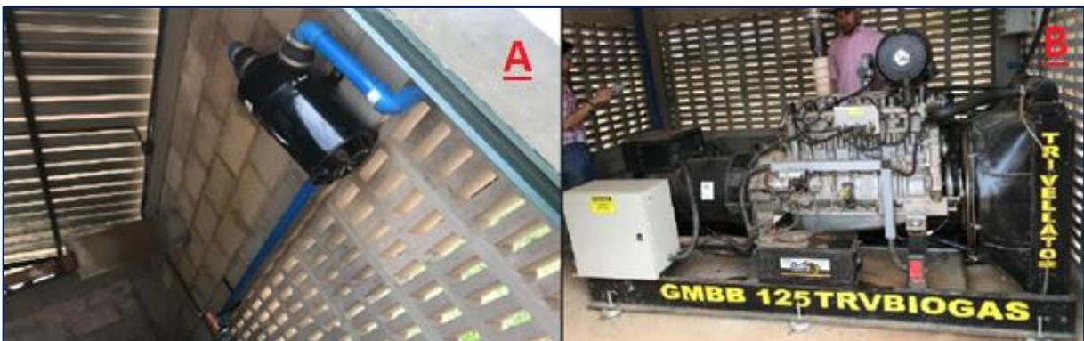
Figura 10. Filtração do biogás e produção de energia elétrica. A: filtro para biogás cru; B: Grupo gerador movido a biogás.
