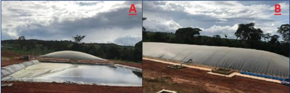
Figura 9. Produção de biogás, A: tanque de armazenamento de biofertilizante; B: Biodigestor tipo lagoa.
