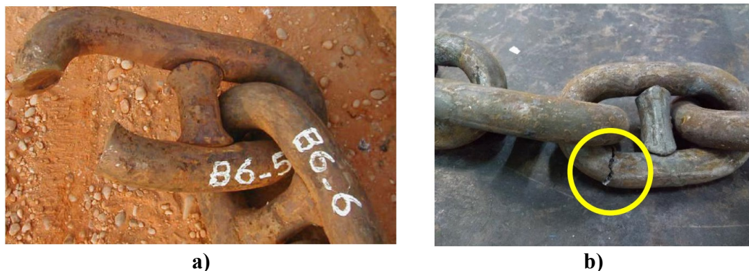
Figura 2.6: a) Falha nos sistemas de ancoragem em uma boia Girassol localizada no litoral da Angola [42] b) Falha no elo devido ao efeito OPB observada após testes experimentais [23]
