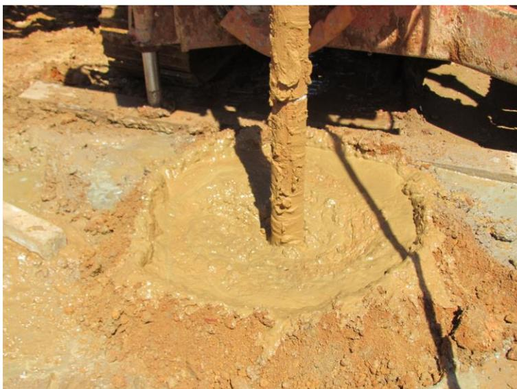
Figura 2.6: Processo da mistura da calda de cimento no solo na execução da estaca DMM.
