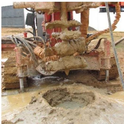
Figura 3.19: Volume excedente da mistura após execução.
