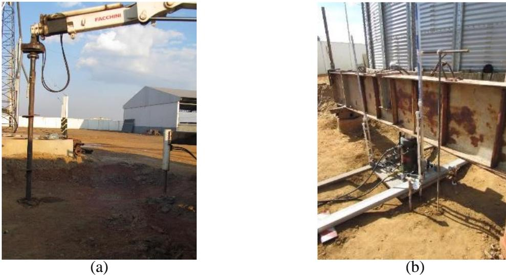
Figura 3.23: Prova de Carga das estacas DMM: (a) processo de cravação da estaca helicoidal de reação com auxílio de caminhão *munck*; (b) montagem da prova de carga com tensiômetros instalados.
