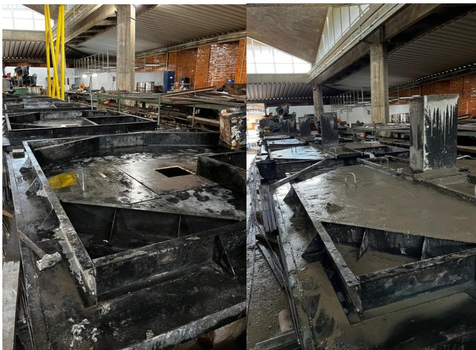
Figura 3.12 - Fôrmas e Concretagem das lajes
