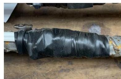
e) Proteção elétrica com fita de alto fusão
