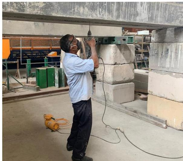
Figura 3.27: Execução dos furos para posicionamento dos ganchos de fixação do reforço
