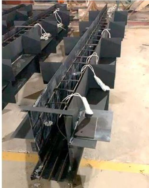
Figura 3.9: Armaduras posicionadas nas fôrmas antes da concretagem
