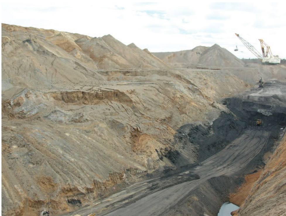
Figura 2.23 - Instabilidade do talude da pilha de spoil devido a deposição sobre material de base de baixa resistência mecânica (Simmons & Yarkosky, 2017).
