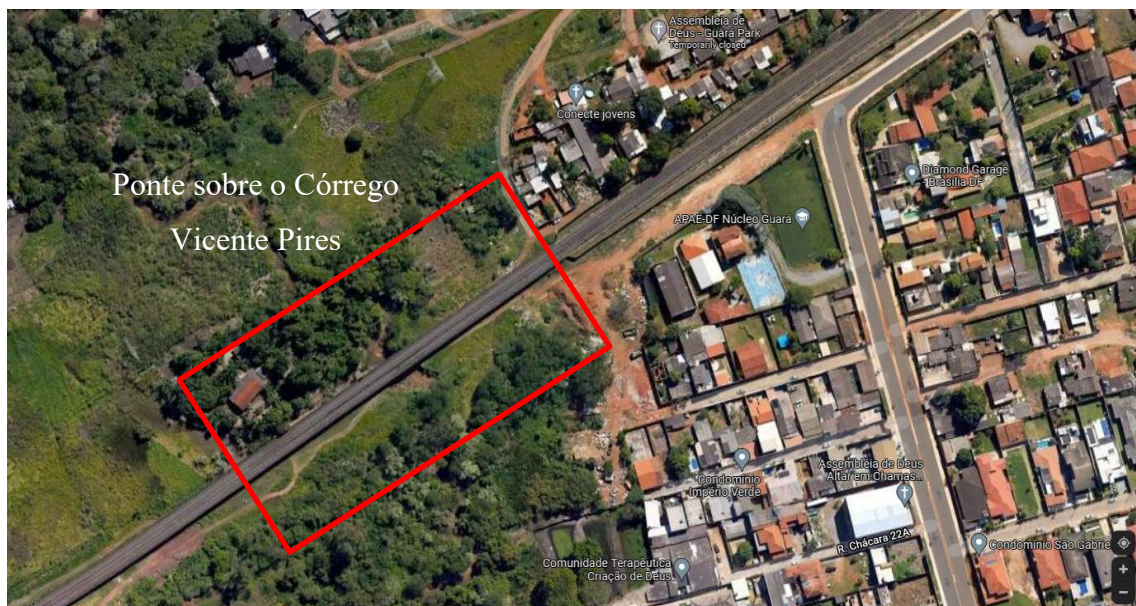
Figura 3-8: Localização geográfica da ponte sobre o córrego Vicente Pires (google imagens).
