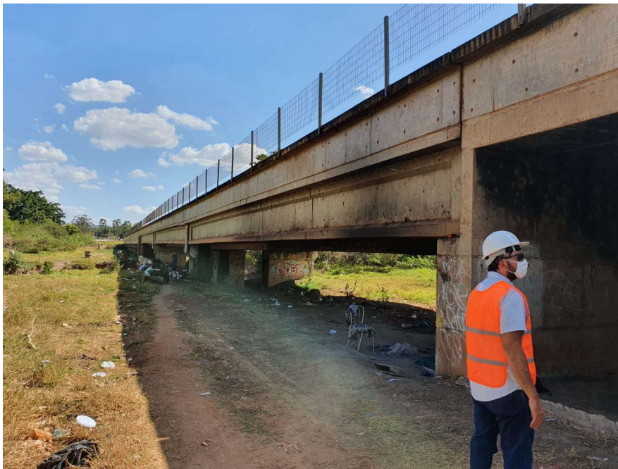
Figura 3-6: Vista da ponte metroviária sobre o Córrego Vicente Pires.
