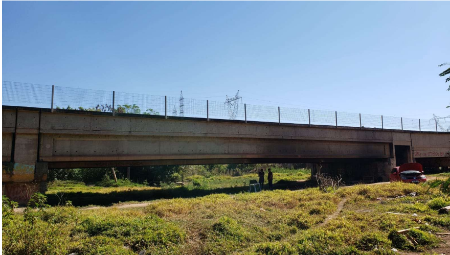
Figura 3-7: Vista frontal do vão monitorado da ponte metroviária sobre o Córrego Vicente Pires.
