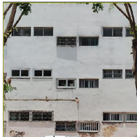
(d) Anomalia de pintura. Fonte: Banco de dados Bauer (2023)
