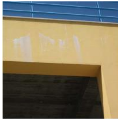
(d) Pulverulência nas fachadas. Fonte: Gaspar (2009)
