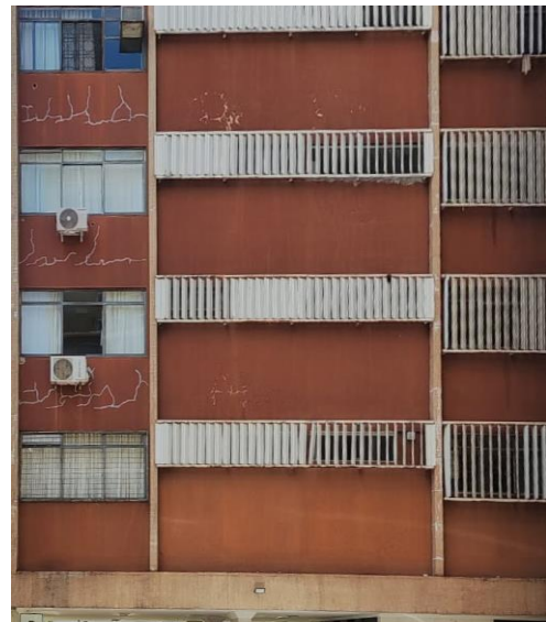
Figura 6.13: Fissuras classificadas com nível de gravidade 3
