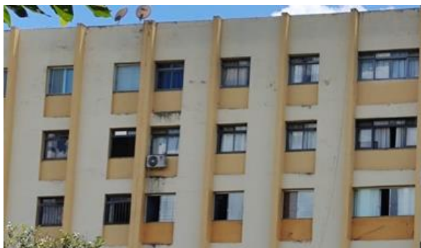
Figura 6.11: Fissuras classificadas com nível de gravidade 1
