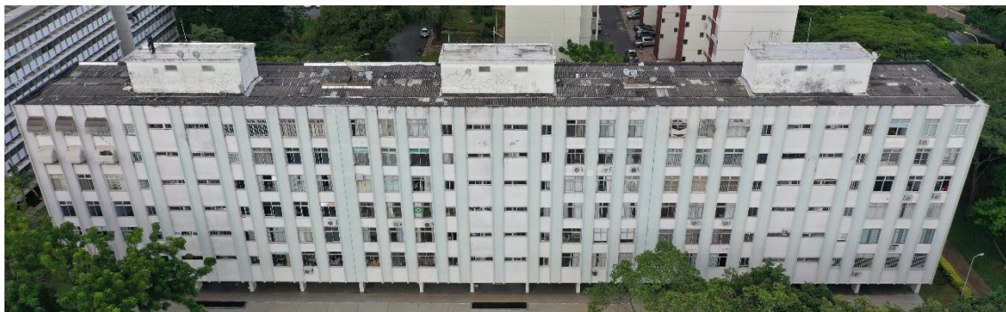
Figura 6.3: Arquitetura dos edifícios inspecionados na Asa Sul
