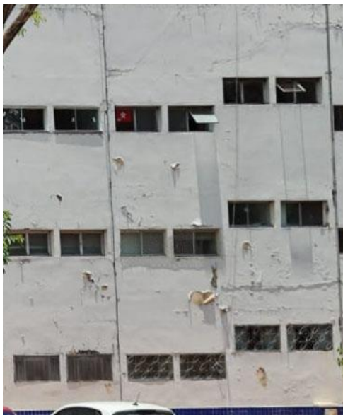
Figura 6.13: Fissuras classificadas com nível de gravidade 3
