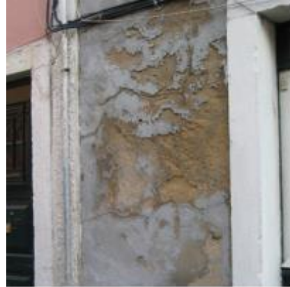
(b) Pulverulência nas fachadas. Fonte: Gaspar (2009)
