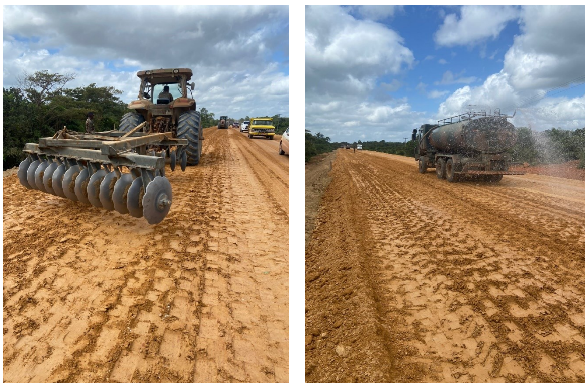
Figura 4.1. a) Trator com grade para homogeneização do material das camadas. b) Caminhão pipa empregado no umedecimento do material das camadas.
