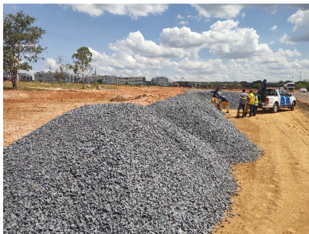
Figura 3.3. Coleta de amostra de BGS em via de acesso à rodovia DF-003 (pedreira 3).
