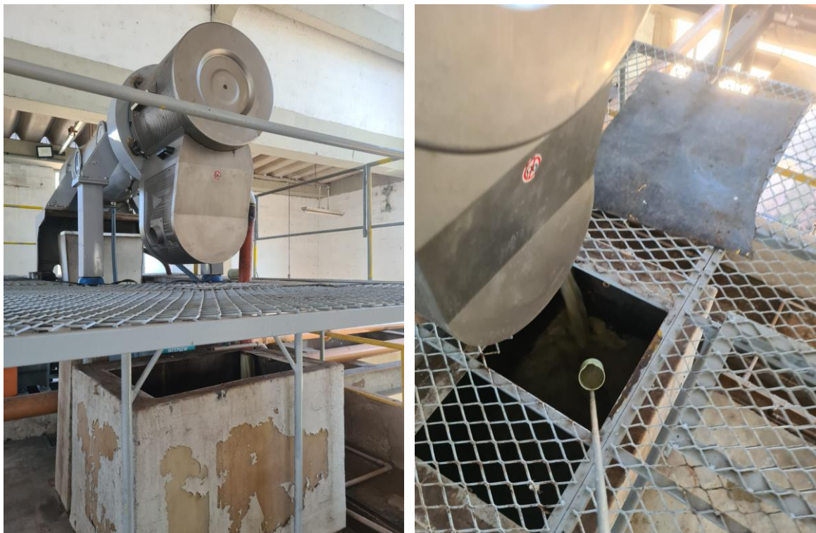
Figura 4.5 - Centrífuga Jumbo da Estação de Tratamento de Esgoto Brasília Norte: a) Estrutura da centrífuga onde foi coletado o efluente clarificado utilizado nos ensaios de adsorção b) saída do efluente clarificado e utensílio de coleta das amostras.
