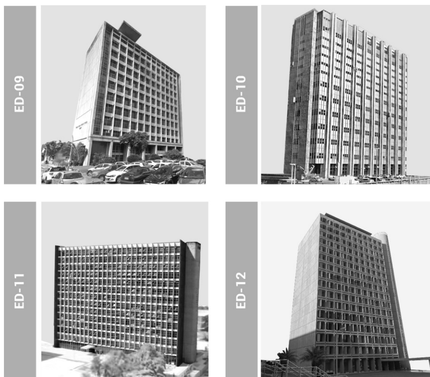
Figura 53 Edificações do Grupo C: . Sede II, TRF 1ª (ED-09); TELECOM (ED-11); SEDE STM (ED-11); e, MORRO VERMELHO (ED-12) Fonte: Adaptado de Google Earth (2021)
