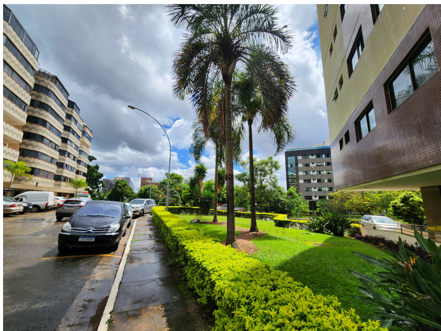
Figura 60. SQN 310, ponto E - acesso aos vazios intencionados restrito por cercamento com vegetação.
