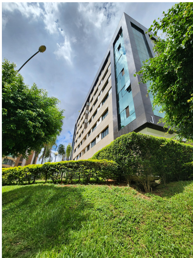
Figura 62. SQN 310, ponto G - topografia utilizada para colocar edifício sobre pedestal enquanto cerca viva impede qualquer acesso.
