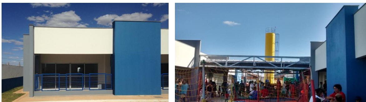
Figura 47. fachadas internas de creche Proinfância tipo 1 Fonte: FNDE
