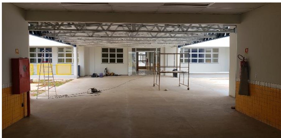
Figura 82. pátio coberto, CEPI Jandaia em obra
