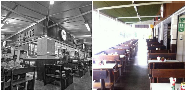
**Figura A- 56:** Bar beirute antes e depois da instalação de forro absorvedor
