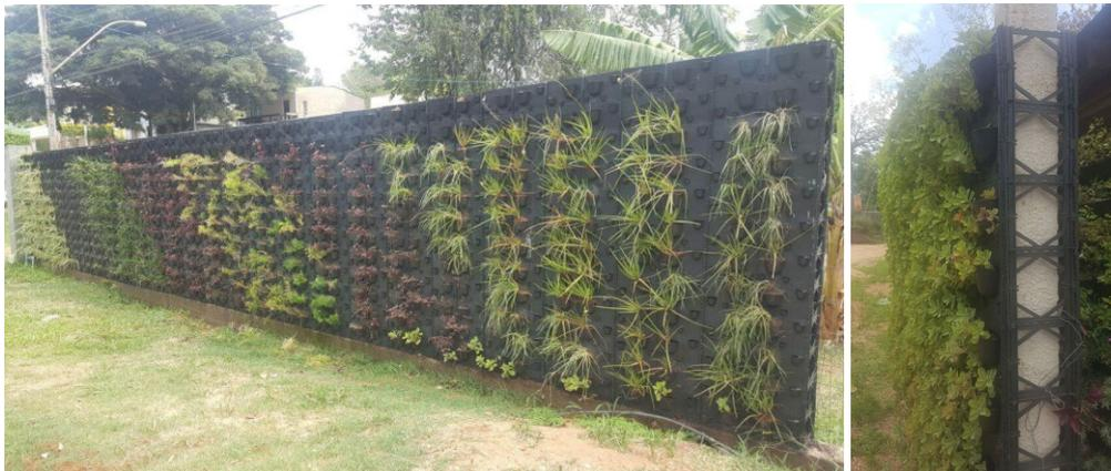
**Figura A- 26: barreira acústica com elementos vegetais**
