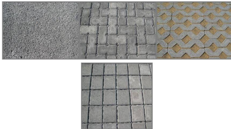
Figura 14. Diferentes tipos de pavimentos permeáveis: da esquerda para direita, de concreto poroso, blocos intertravados Octabrick, blocos vazados de concreto e blocos de concreto Rima.
