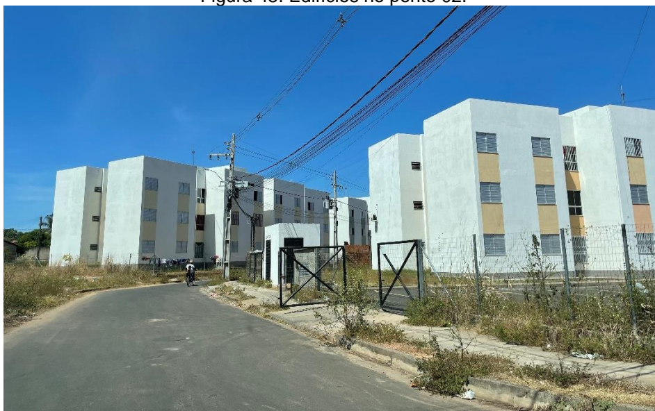
Figura 45. Edifícios no ponto 02.
