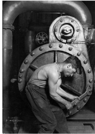
Fig. 36: Mecânico da casa de força, 1920. Foto de Lewis Hine.
