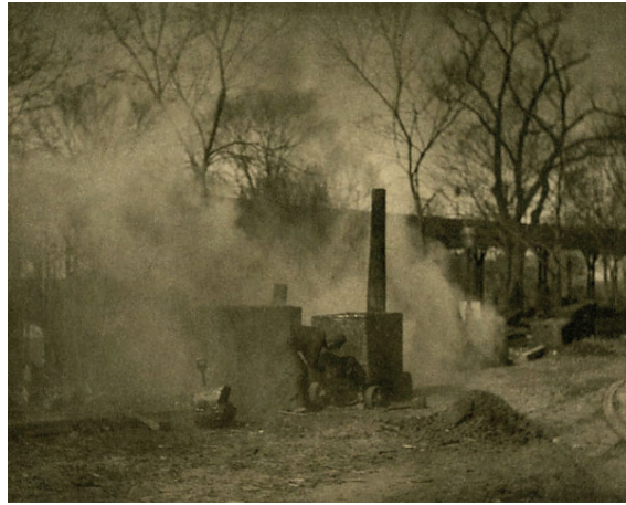
Fig. 14: Pavimentador de asfalto, New York , 1892. Foto de Alfred Stieglitz
