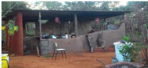
Figuras 130 e 131: Cozinha construída em barro e madeiras reaproveitadas e Shaya para substituir a couve. Fonte: Acácio Machado.
